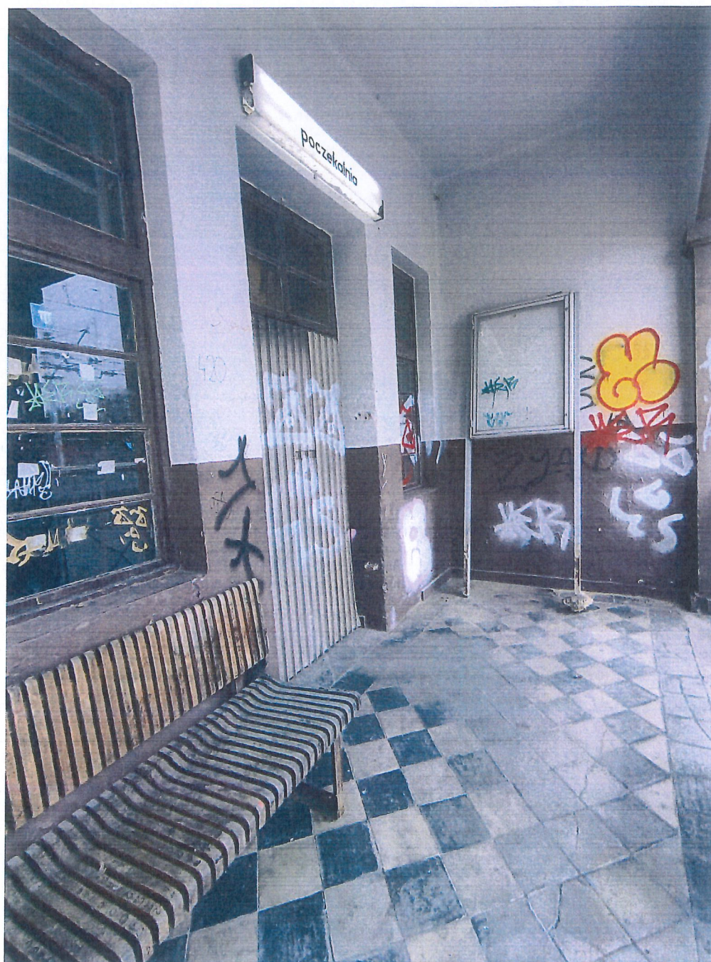
Budynek dworca – oryginalne zabytkowe płytki
