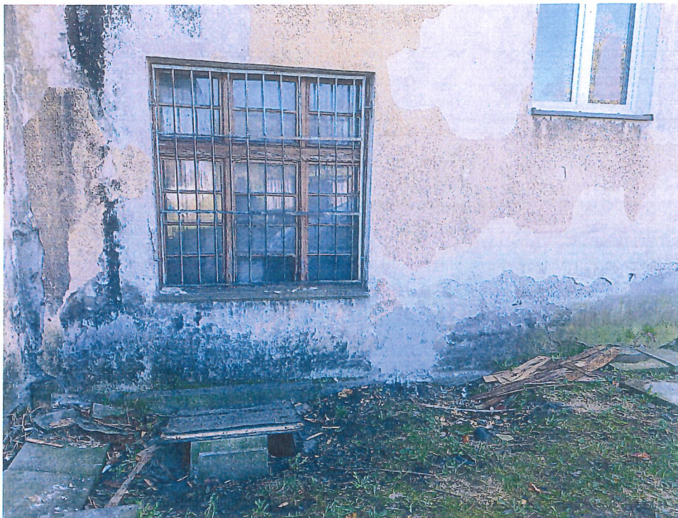
Budynek dworca – elewacja boczna
