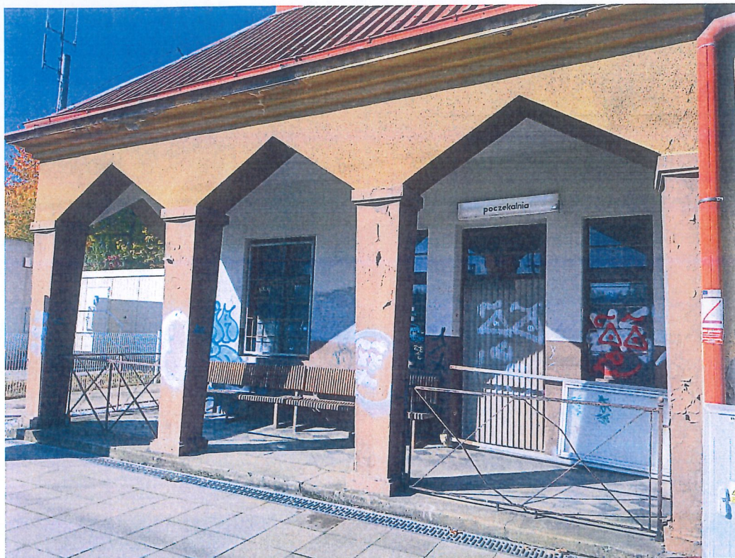
Budynek dworca - podcienie
