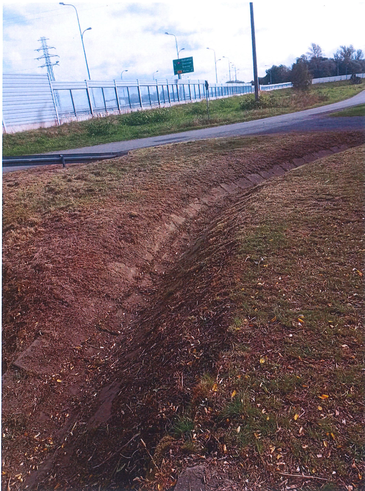
Poniżej Ciek w Harbutowicach przy ul. Rubinowej
