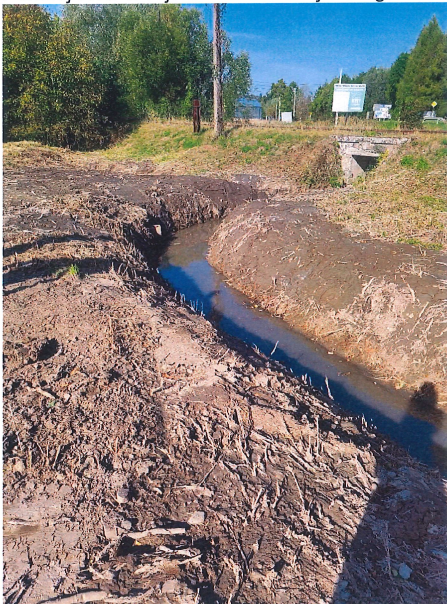
Poniżej Rów w rejonie ul. Bielskiej w Pogórze
