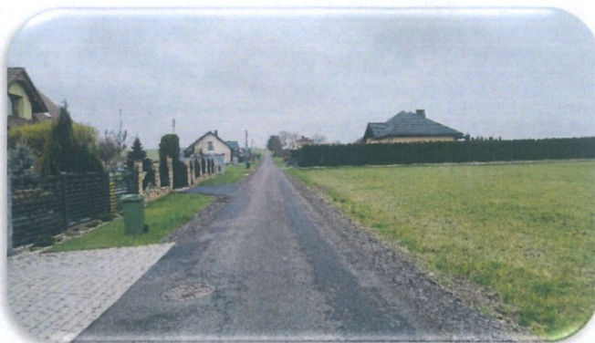
- Akacyjowa w Pierścicu gdzie dodatkowo w zakresie remontu wykonana została również stabilizacja podbudowy spoiwem hydraulicznym.
