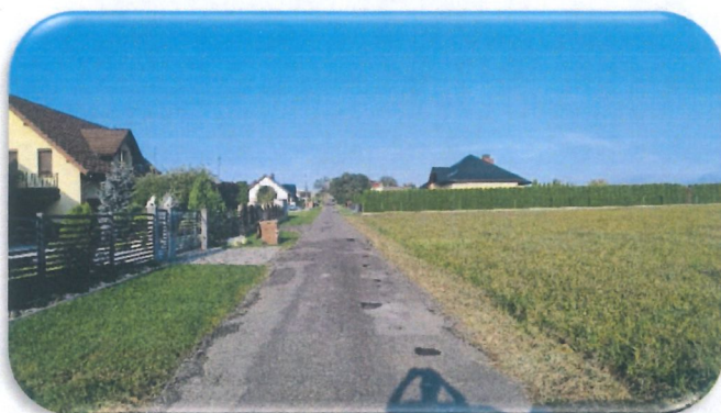
- Akacyjowa w Pierścicu gdzie dodatkowo w zakresie remontu wykonana została również stabilizacja podbudowy spoiwem hydraulicznym.
