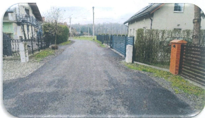
- Akacyjowa w Pierścicu gdzie dodatkowo w zakresie remontu wykonana została również stabilizacja podbudowy spoiwem hydraulicznym.
