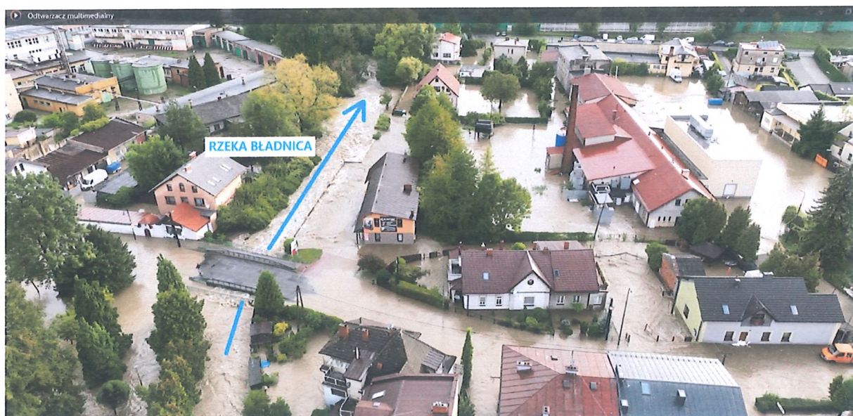
Rzeka Bładnica poza korytem w dniu 15.09.2025r. – miasto Skoczów – przed ujściem do rzeki Wiśły (na zdjęciu widoczny most w ciągu ulicy Ustrońskiej)
