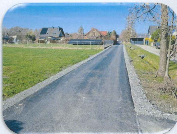
fot. – ul. Świetlicowa – remont częściowy odcinka nawierzchni w technologii masy asfaltobetonowej (przed i po remoncie)
