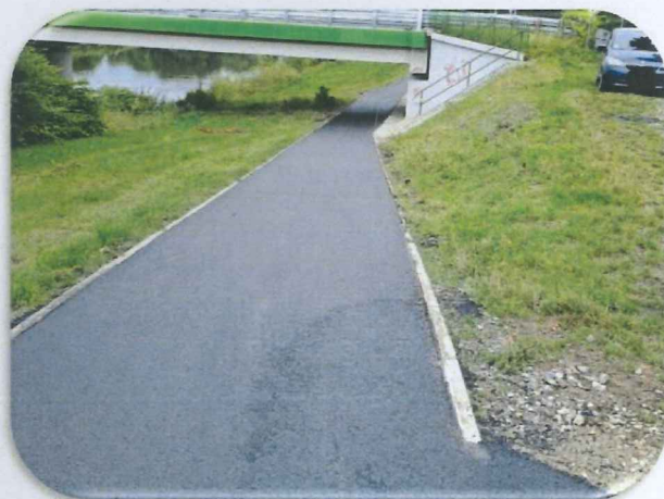
fot. – ścieżka pieszo-rowerowa – remont częściowy odcinka nawierzchni pod obiektem mostowym
