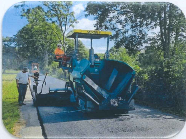
fot. – ul. Gołyska – remont częściowy odcinka nawierzchni w technologii masy asfaltobetonowej
