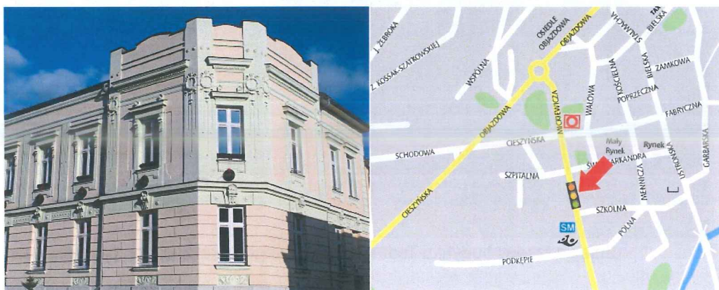
Zdjęcie fasady budynku głównej siedziby MCK „Integrator”, lokalizacja graficzna.
