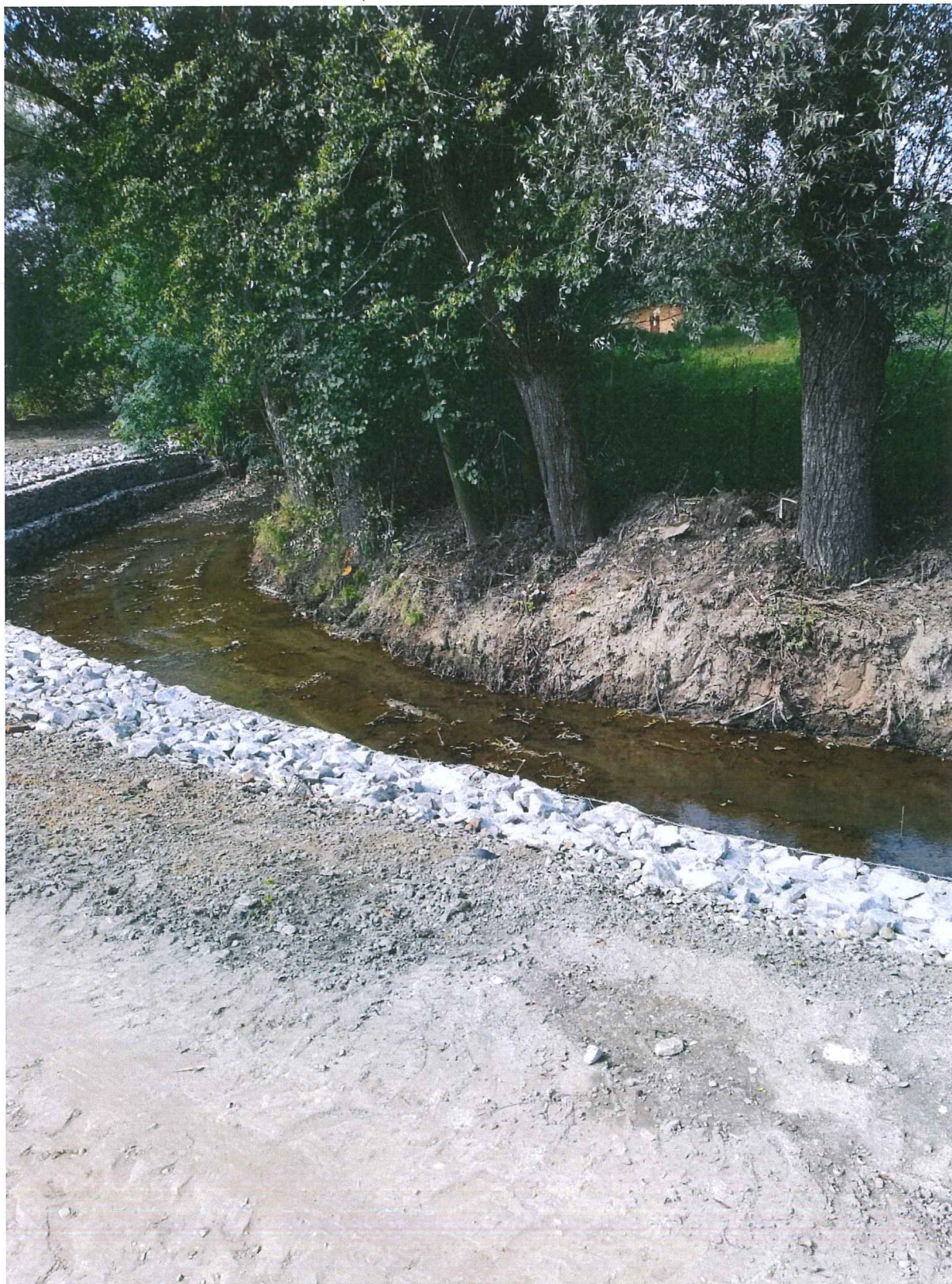
Awaryjny remont cieków wodnych w Kowalach przy ul. Kowali
