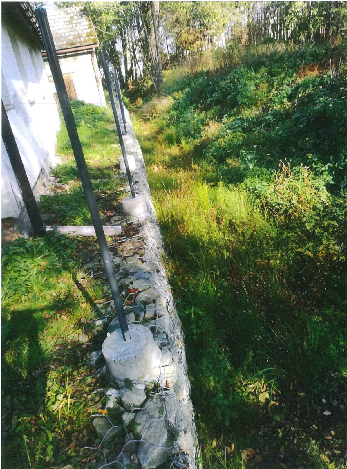
Udrożnienie Młynówki Harbutowickiej na odcinku 270 m w rejonie ul. Żyznej w Harbutowicach
