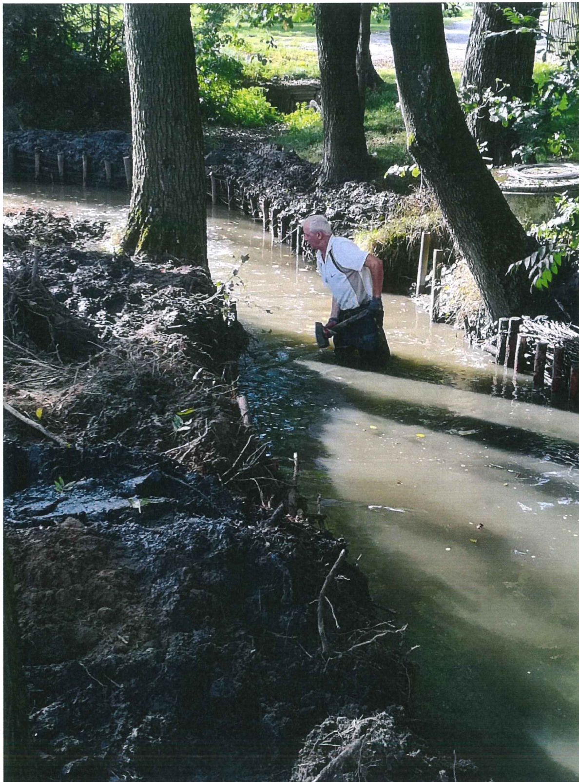
Wykonanie awaryjnego udrożnienia koryta cieku Lewobrzeżnej Młynówki Kiczyckiej w Ochabach Wielkich w rejonie ul. Cesarskiej
