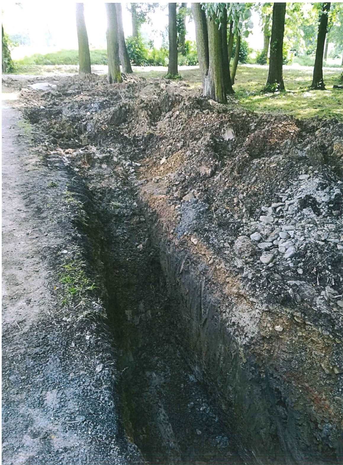
Awaryjny remont kanalizacji deszczowej w rejonie Szkoły Podstawowej nr 8 na Górnym Borze w Skoczowie
