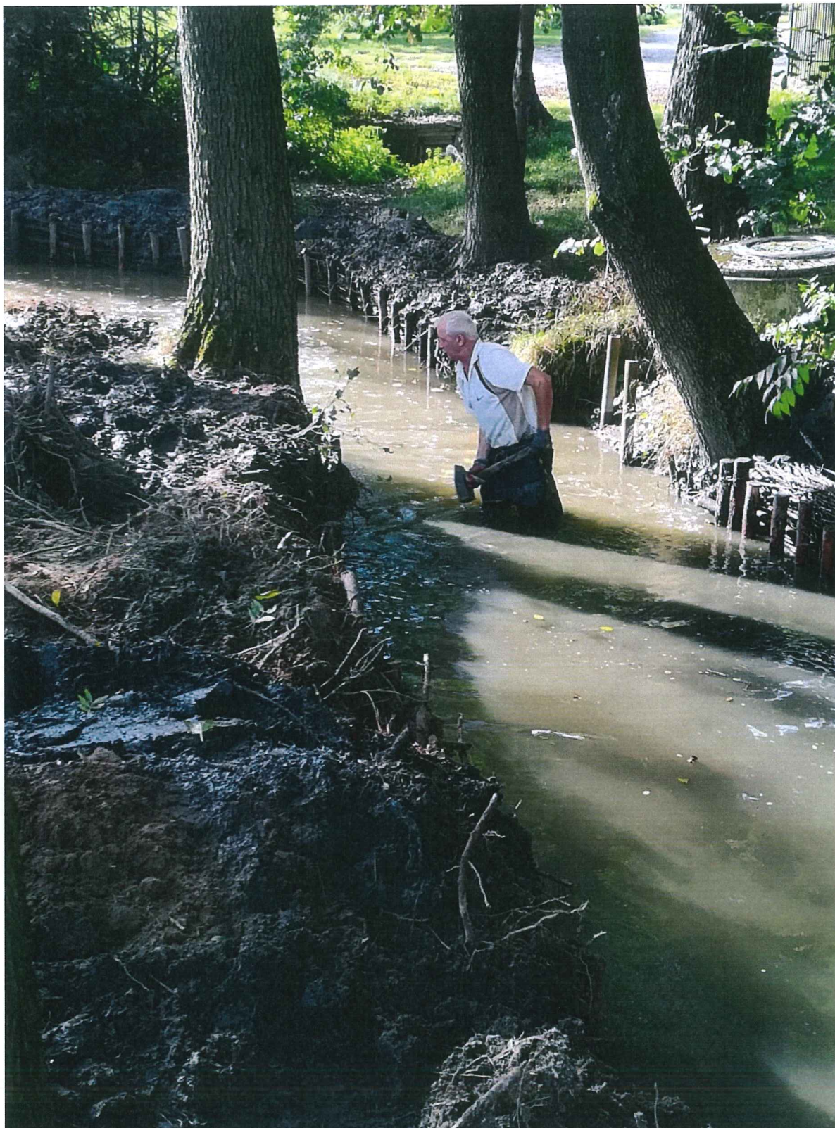
Wykonanie awaryjnego udrożnienia koryta cieku Lewobrzeżnej Młynówki Kiczycyckiej w Ochabach Wielkich w rejonie ul. Cesarskiej
