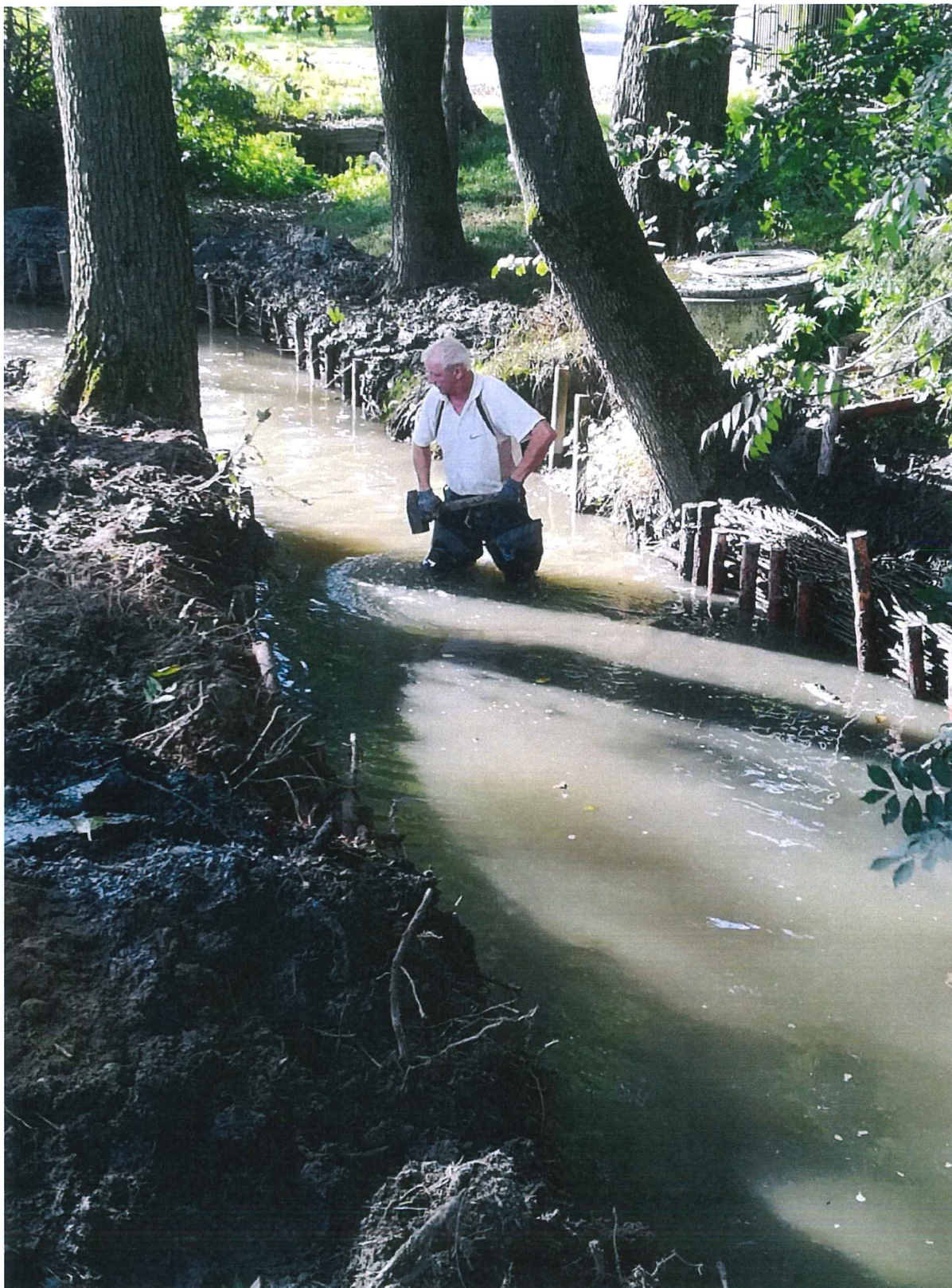
Wykonanie awaryjnego udrożnienia koryta cieku Lewobrzeżnej Młynówki Kiczyczej w Ochabach Wielkich w rejonie ul. Cesarskiej
