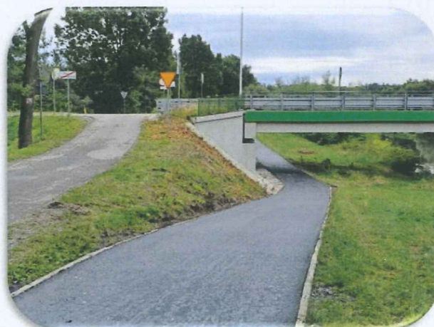
fol. – ścieżka pieszo-rowerowa – remont cząstkowy odcinka nawierzchni pod obiektem mostowym
