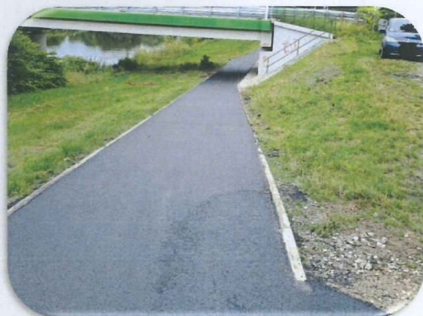
fol. – ścieżka pieszo-rowerowa – remont cząstkowy odcinka nawierzchni pod obiektem mostowym
