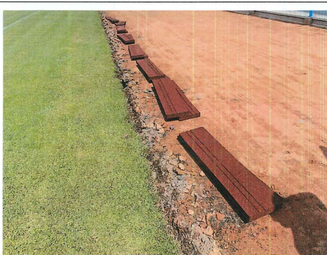
Wymiana krawężników przy boisku na Stadionie Miejskim
