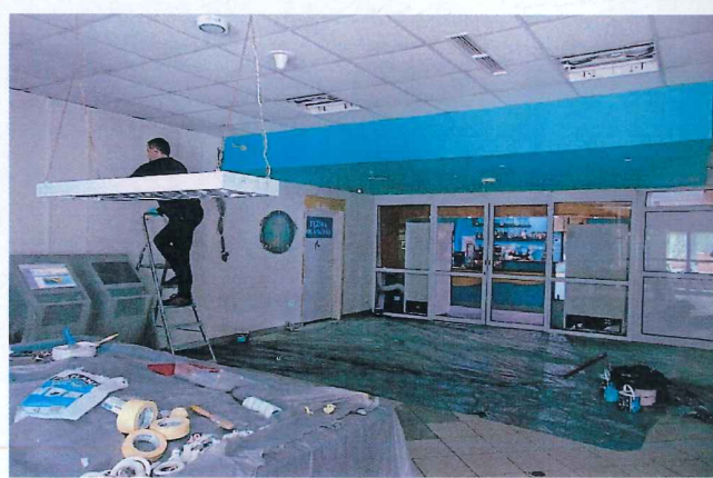
Malowanie ścian w salce konsumpcyjnej w Krytej Pływalni „Delfin”
