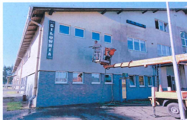
Mycie elewacji budynku Krytej Pływalni Delfin
