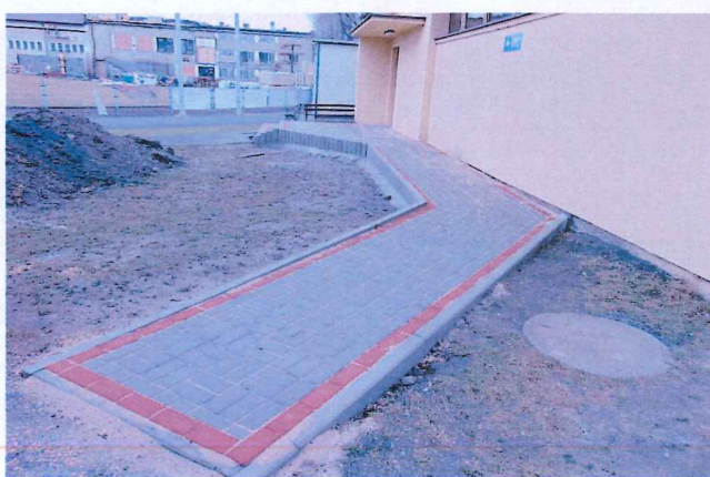
Budowa podjazdu dla osób niepełnosprawnych przy ubikacjach dla kibiców na Stadionie Miejskim
