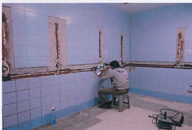
Remont instalacji wodnej pod natryskami na basenie w Krytej Pływalni „Delfin”
