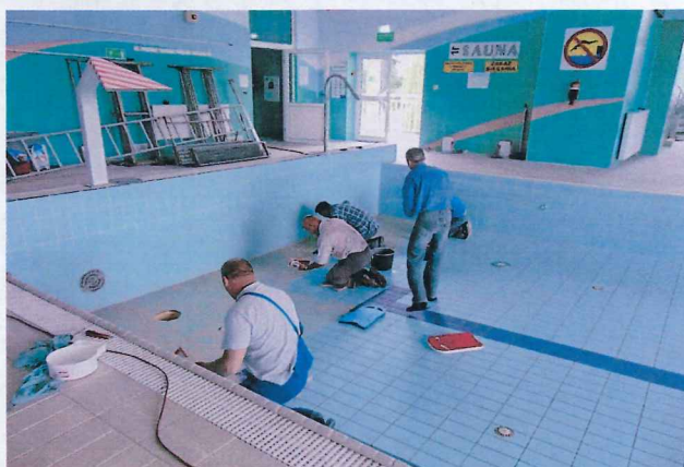
Uzupełnienia fug w niecce basenu rekreacyjnego
